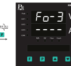
แสดงค่า Previous Fault Output 3
